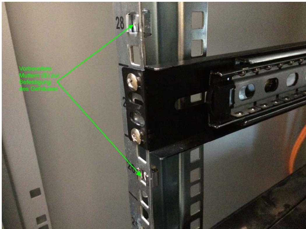
Sorgen Sie vorne auch für eine Befestigungsmöglichkeit (z. B. Mutteln (B)) des Gehäuses am Rack.
