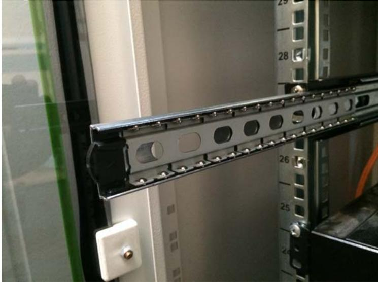
Für diesen Arbeitsschritt benötigen Sie eventuell eine zweite Person. Heben Sie nun das Gehäuse hoch und stecken Sie die am Gehäuse montierten Schienen in die im Rack montierten Schienenenden. Schieben Sie das Gehäuse ganz in das Rack hinein. Jetzt können Sie das Gehäuse mit Schrauben am Rack (Muttern (B)) befestigen.
